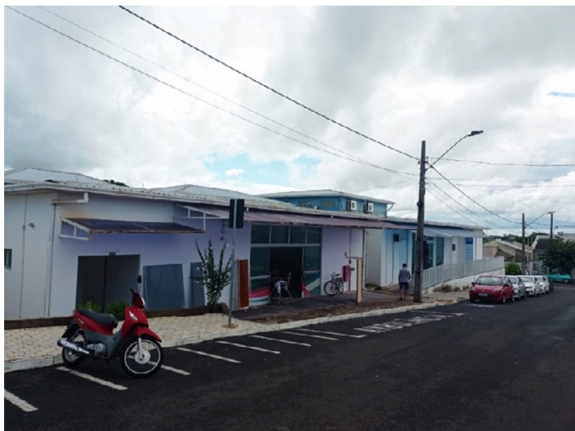
Central de gases no PAM
