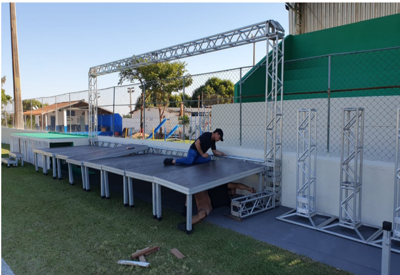
Detalhes finais das montagens da estrutura
