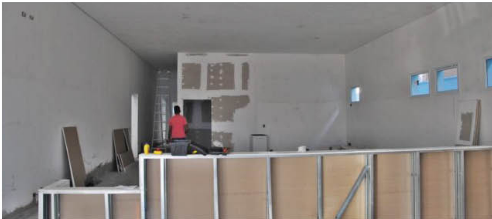
Novo prédio da Farmácia Municipal, em construção na rua General Osório
