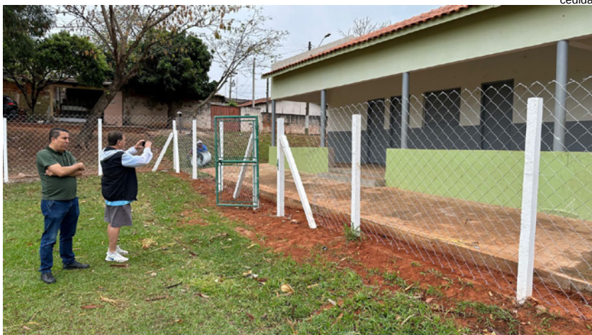
Prefeito André Lemos acompanhou a finalização da instalação dos alambrados
