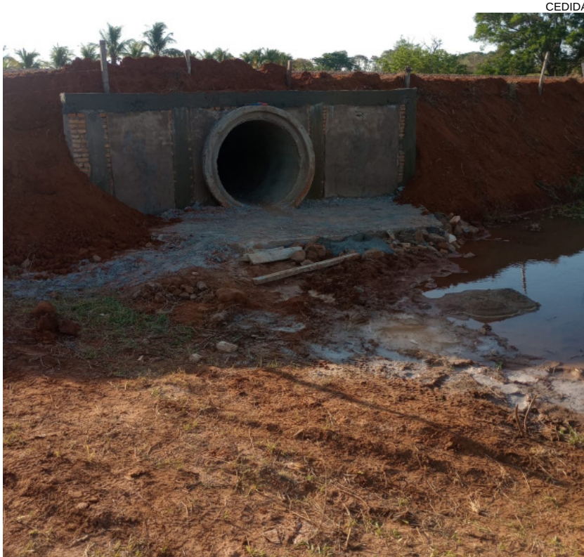
No local foram colocadas tubulações para passagem da água das chuvas
