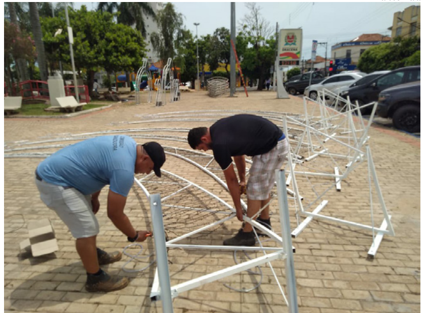
Iluminação natalina sendo instalada na praça
