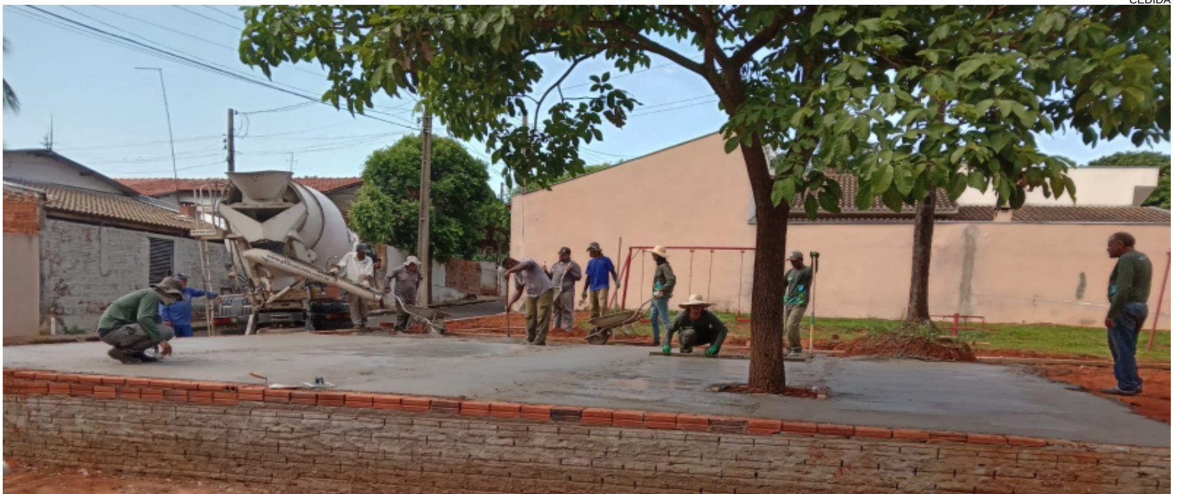
Praça no Jussara, ao lado do Bortolato está sendo construída
