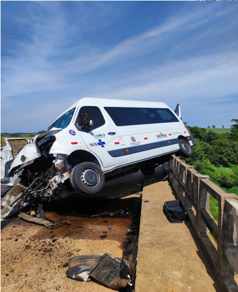
Van ambulância bateu em mureta de concreto da ponte na rodovia
