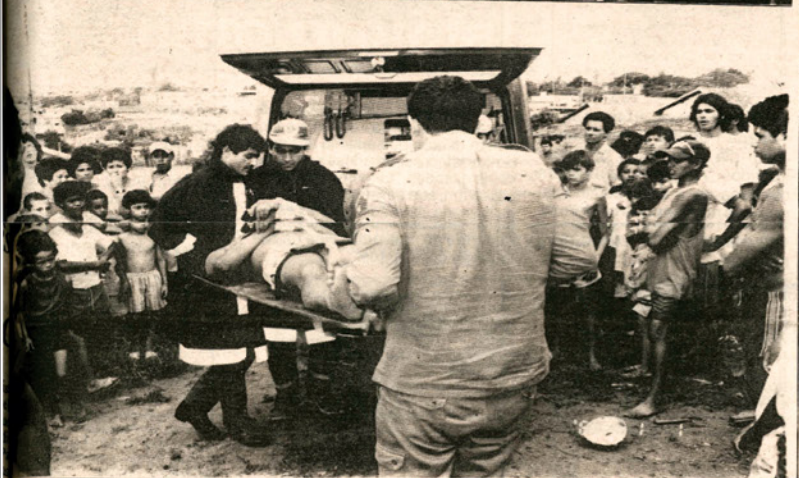
Estrutura metálica de uma empresa do distrito industrial caiu sobre a residência de Gildo Augusto da Silva (foto acima). No flagrante inferior Gildo quando era transportado para a Santa Casa
