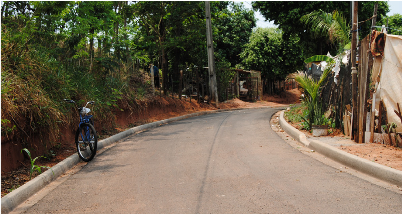
Rua Chapéu de Couro
