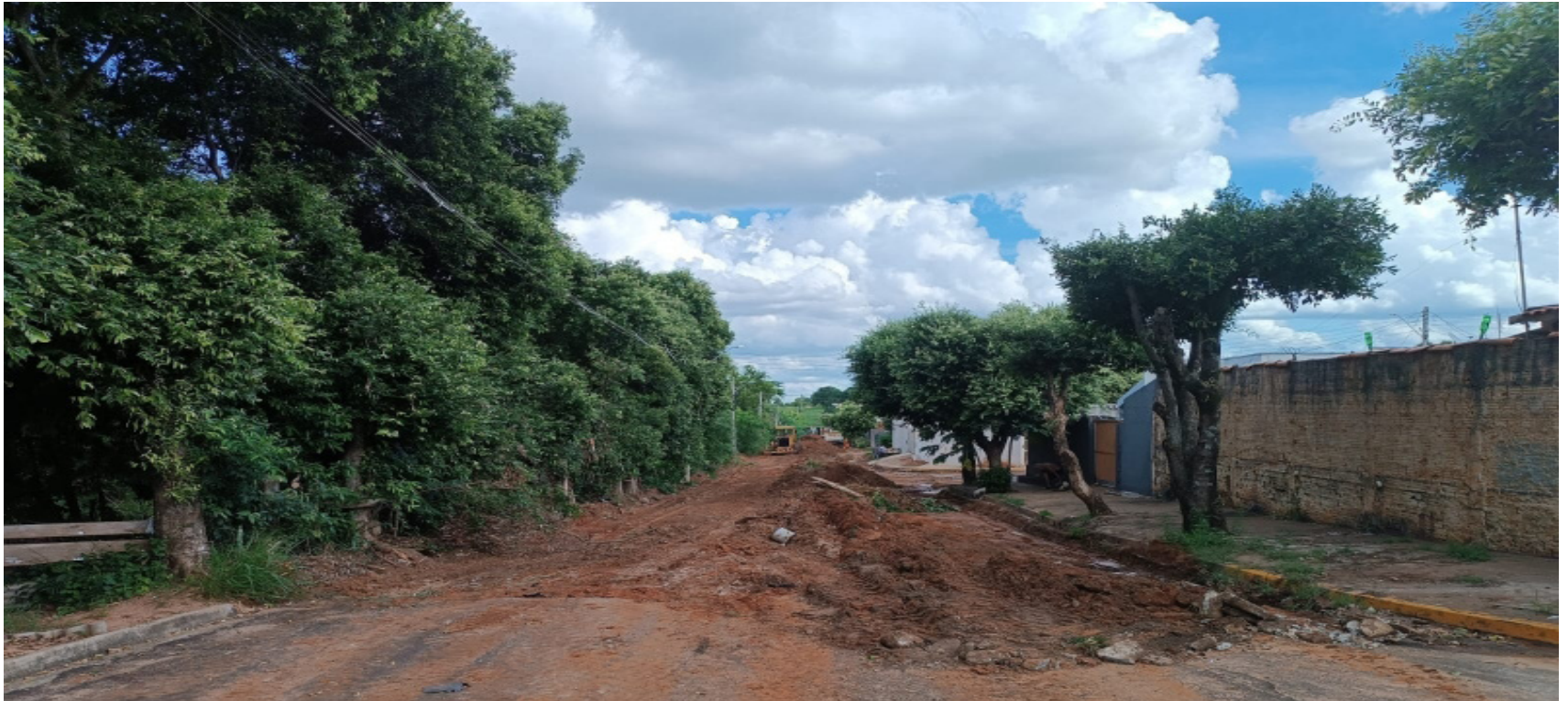
Rua Palmira Reigota Stelatto: trabalhos para início da pavimentação começaram na semana que passou
