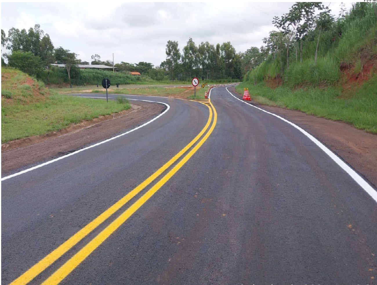
O trânsito no local foi liberado no término das obras sábado (20)
