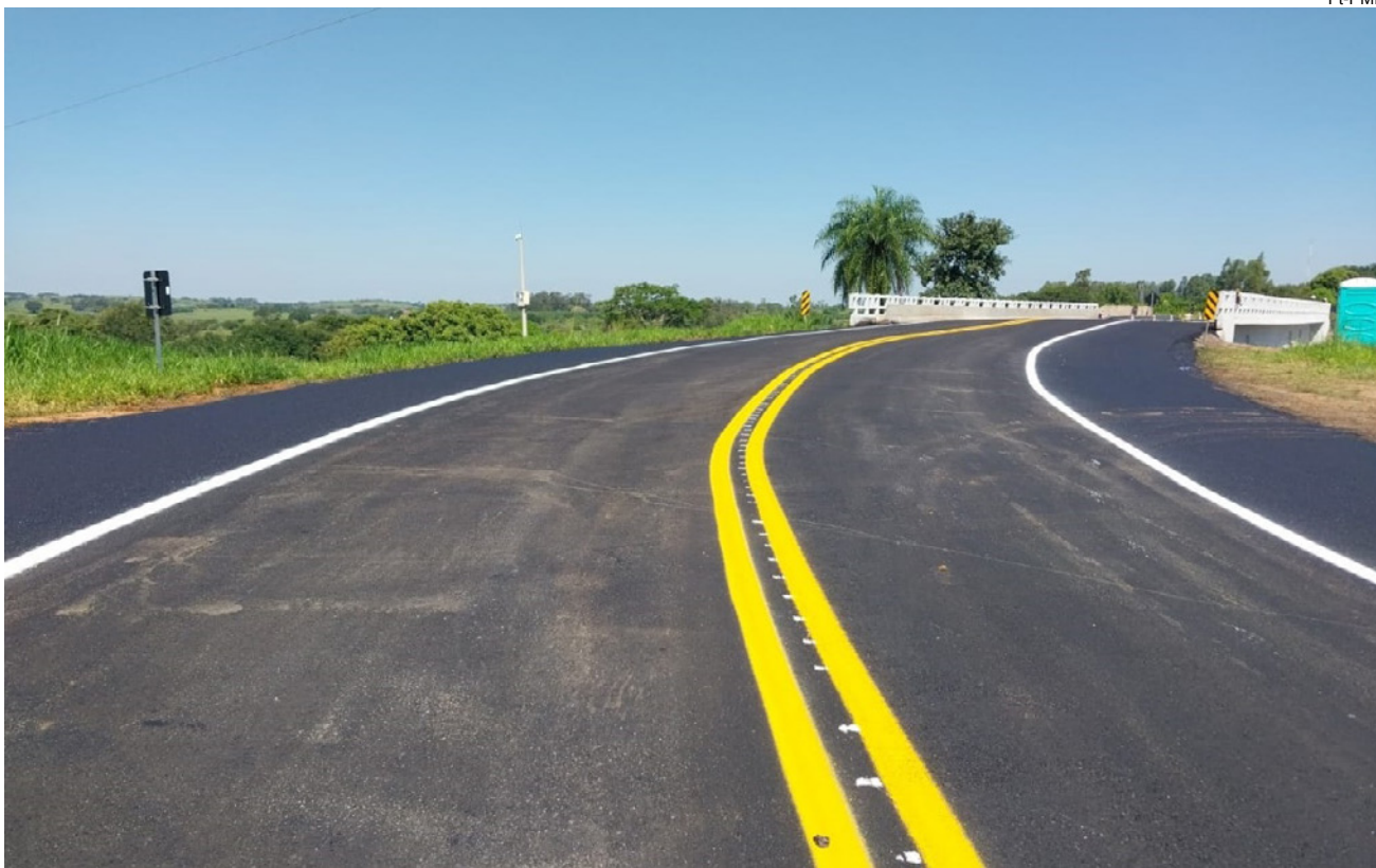
O viaduto passou a ter 40 centímetros a mais de altura para aumentar segurança
