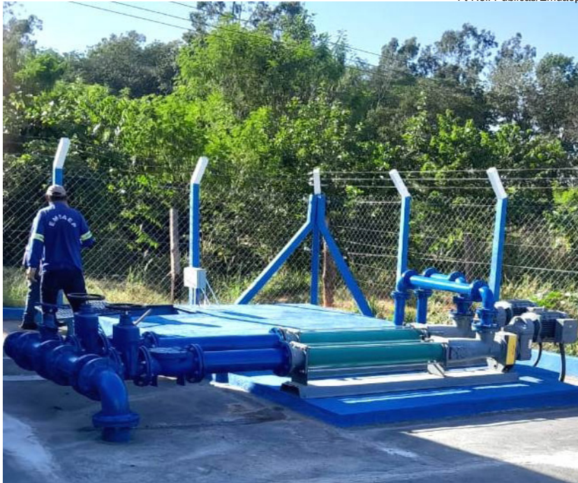
Nova estação de elevatória no bairro Novo Horizonte
