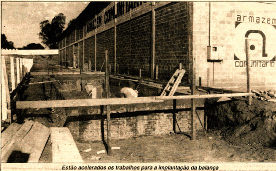
Estão acelerados os trabalhos para a implantação da balança
