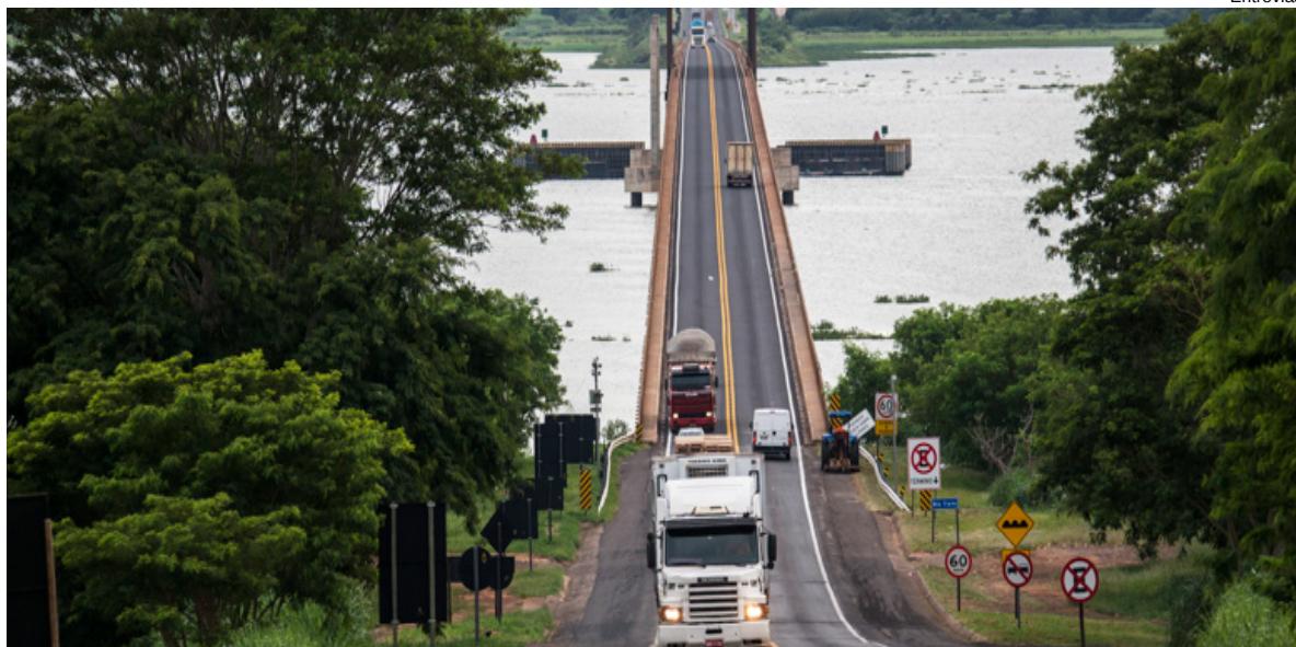
Ponte Eng. Gilberto Palm Pamplona, fica sobre o rio Tietê: obra é avaliada em mais de R$ 350 milhões
