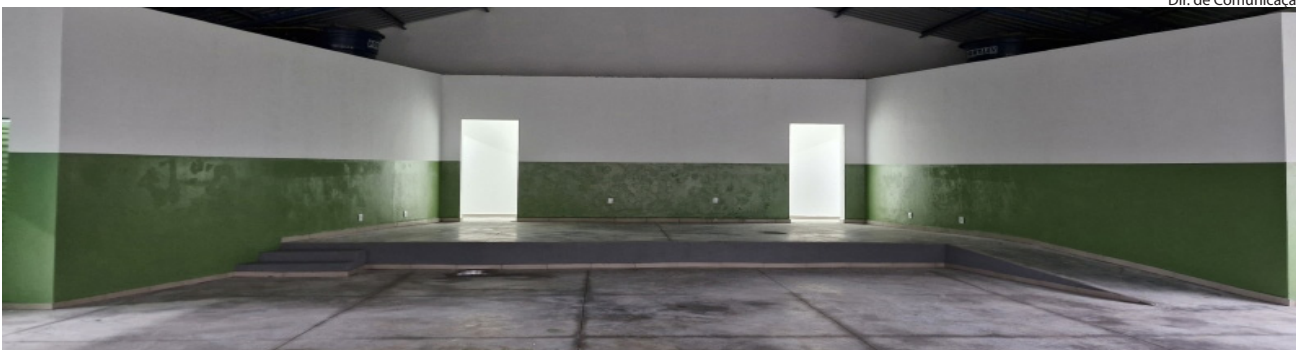
Revitalização contou com troca do piso do salão, troca das instalações elétricas e pintura geral
