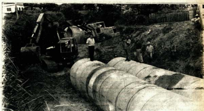
A galeria conta com linha dupla de tubos
