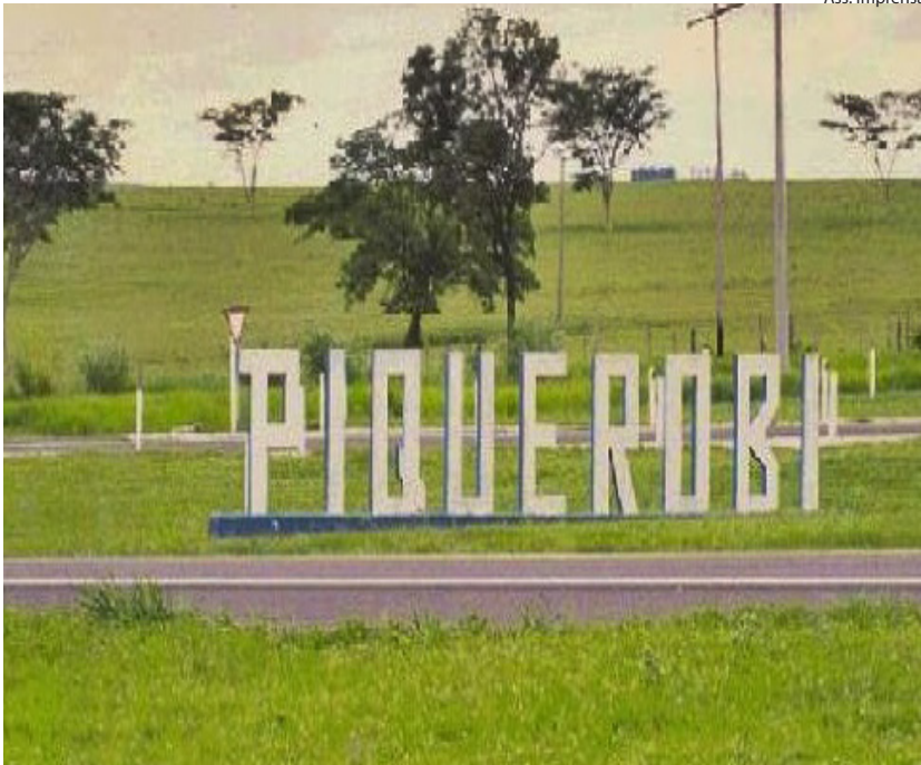
Obras no acesso à rodovia Raposo Tavares, em Piquerobi
